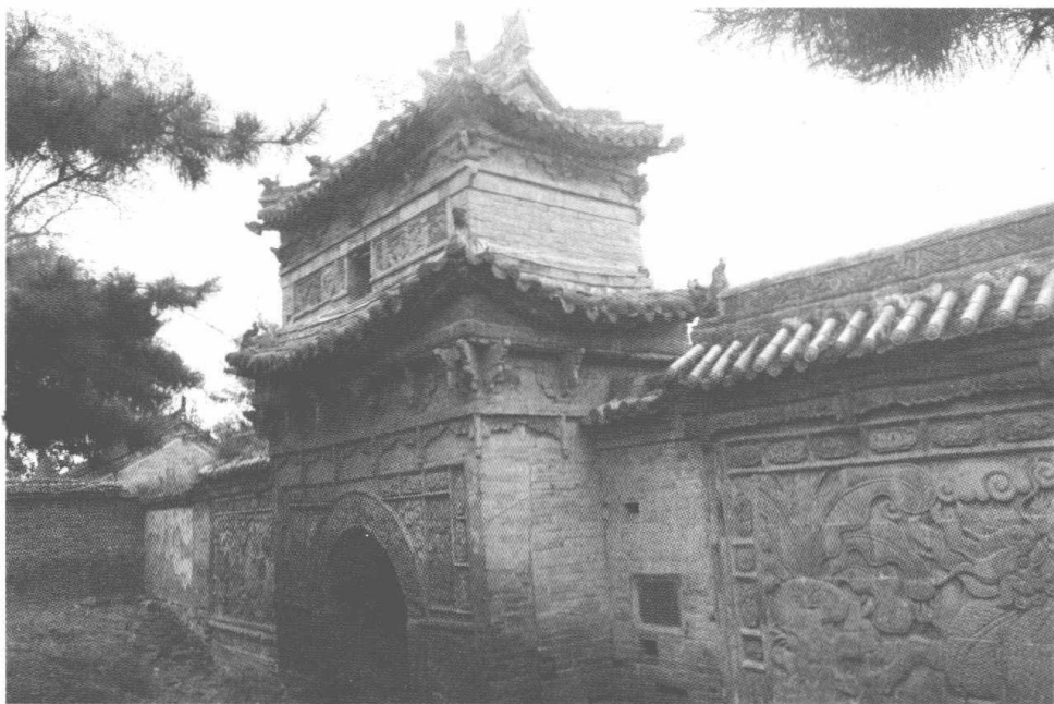
图 2.1.2 安国寺火墙门楼
