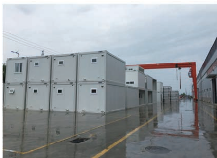
(d) 室外成品存放区
