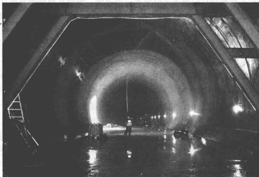
图 1.2 整体式衬砌结构浇筑完成后的现场效果图
