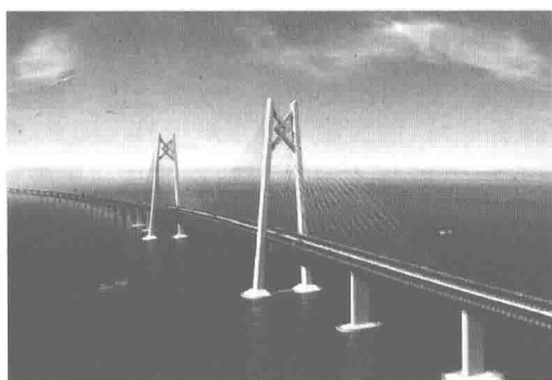
(a) 中国港珠澳大桥
