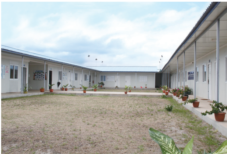
图 1-3 宿舍区工程营地
