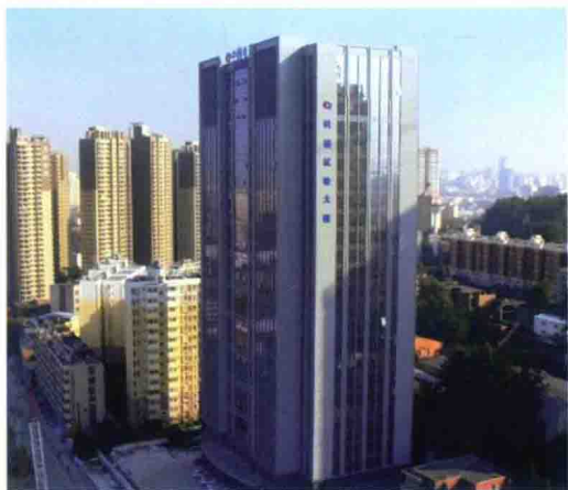
云南省昆明市科研试验大楼，由昆明院设计
