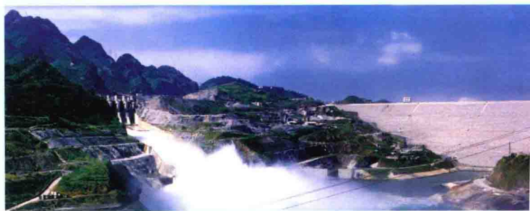
天生桥一级水电站，位于红水河上游黔、桂两省（自治区）交界的南盘江干流上，由昆明院勘测设计，2008年荣获全国优秀工程设计银奖
