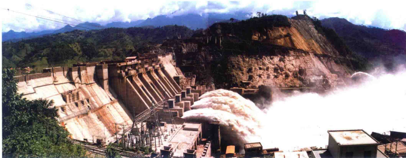
漫湾水电站，位于云南省西部的澜沧江中游河段，由中国电建集团昆明勘测设计研究院有限公司（以下简称昆明院）勘测设计，2000年荣获国家优秀工程勘察金奖
