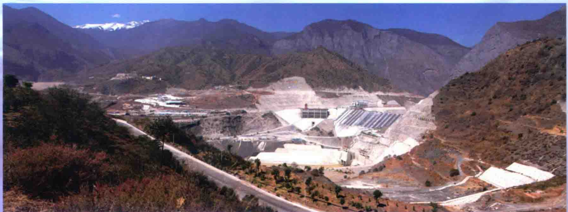
梨园水电站，位于云南省玉龙县与香格里拉县交界的金沙江中游河段，由昆明院勘测设计
