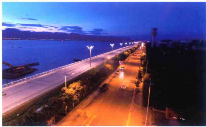
云南省昆明市草海大堤加固提升及水体置换通道工程，由昆明院勘测设计
