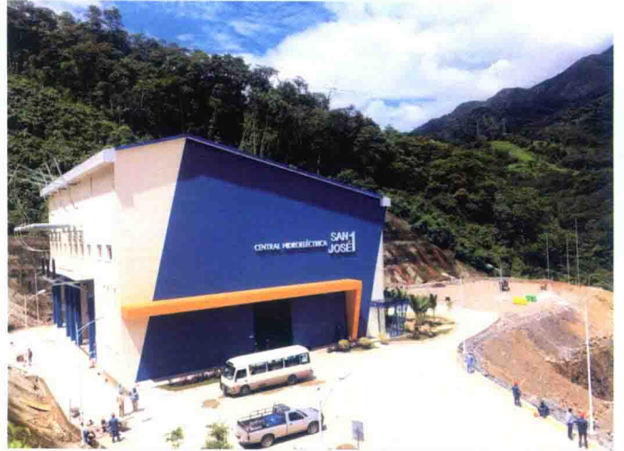
玻利维亚圣何塞 1 级电站，昆明院承担工程总承包
