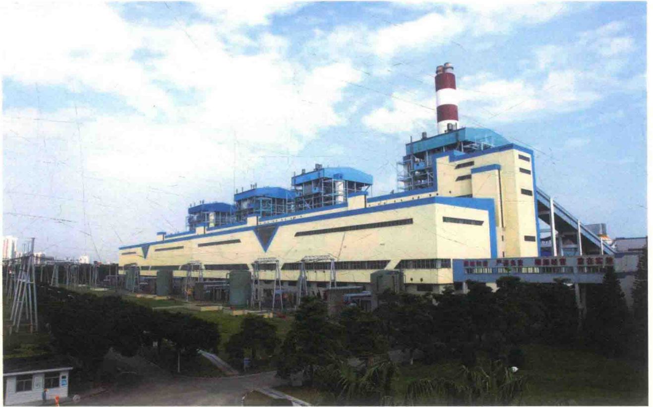
由国家能源投资公司、福建投资开发总公司、福建省电力局、厦门国际信托投资公司、香港中银集团投资有限公司合资兴建的国家投资多元化办电试点工程——厦门嵩屿电厂一期工程，装机2台总容量60万千瓦（摄于1996年）
