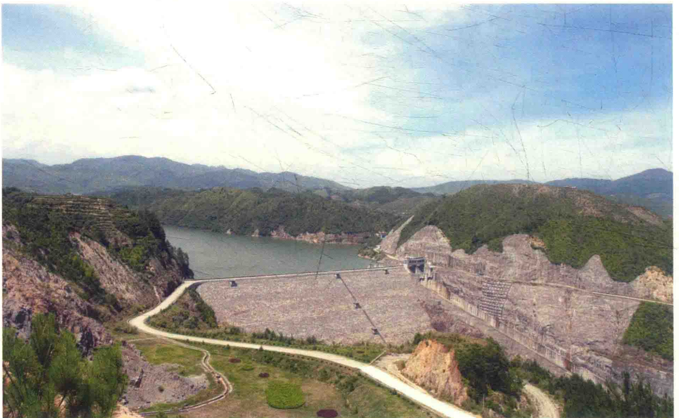
由福建省电力局、闽东能源投资有限公司、福建亿力电力股份有限公司合资兴建的穆阳溪一级龙头水库电厂——周宁芹山水电厂，装机2台总容量7万千瓦（摄于2000年）
