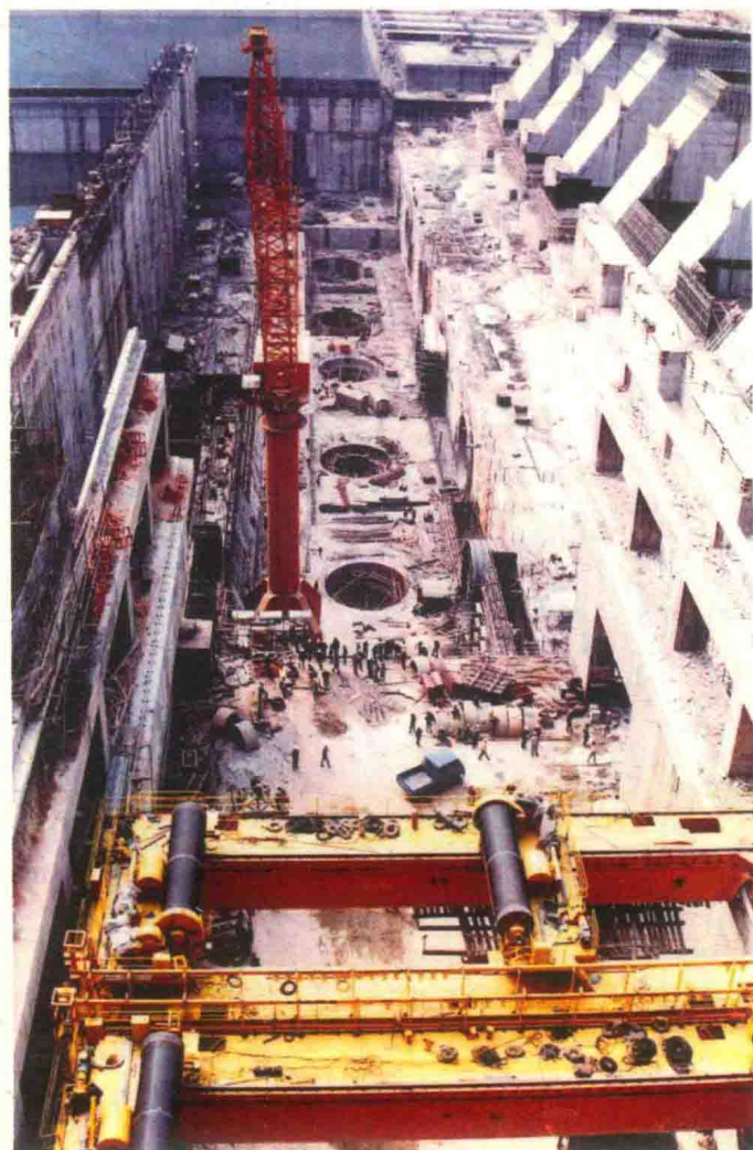
建设中的水口水电站（摄于1991年）
