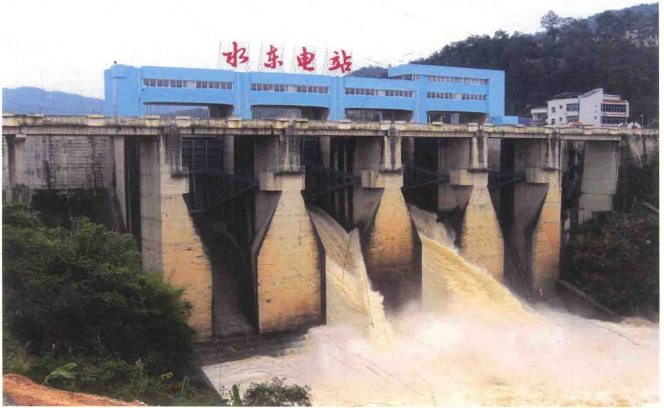
由尤溪县政府、闽能水电开发有限公司、国投电力公司、尤溪县力高电力有限公司、福建投资开发总公司合资兴建的尤溪水东水电站，装机4台总容量8万千瓦（摄于1995年）
