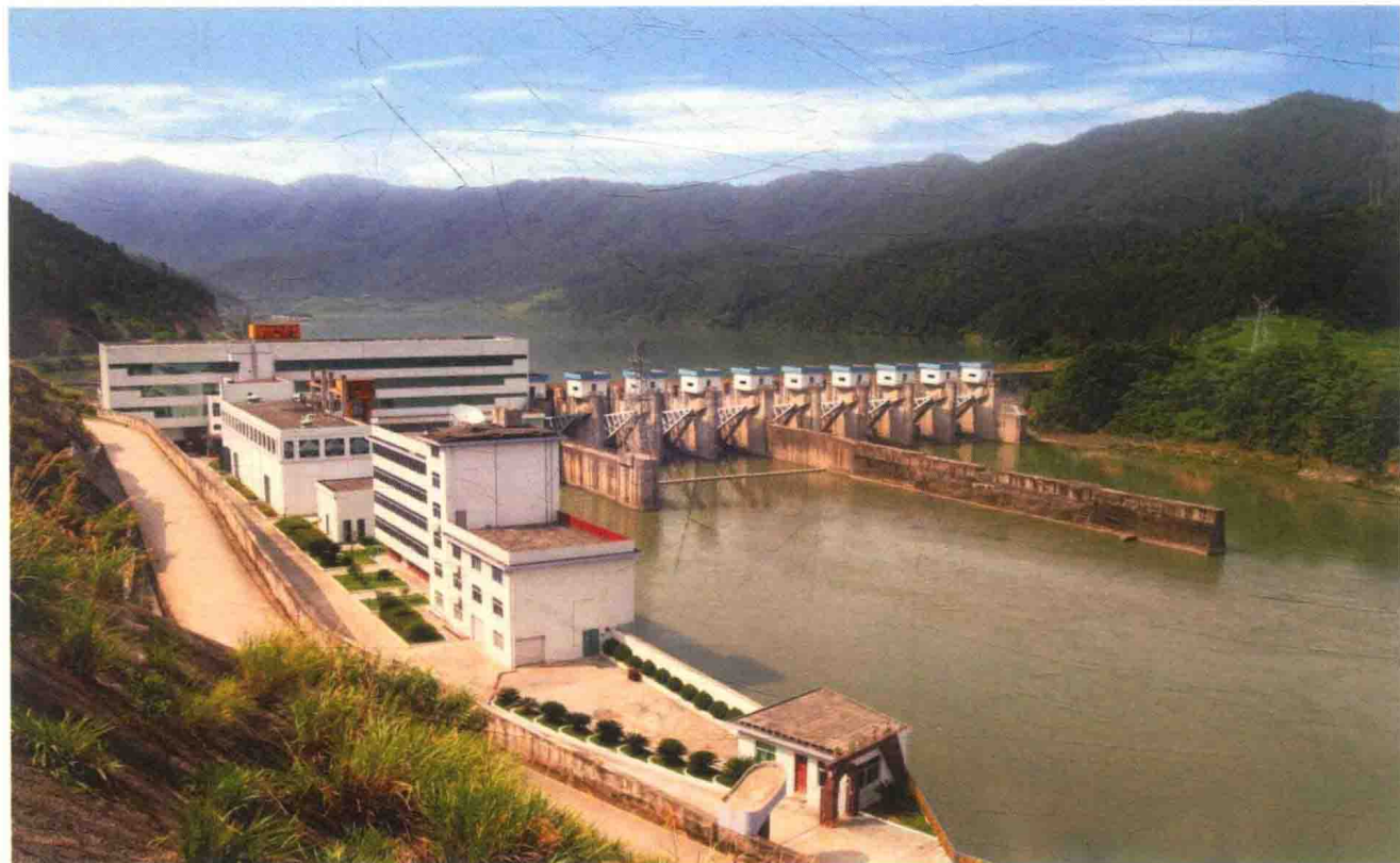
由闽能水电开发公司、国投电力公司、将乐水电投资发展总公司合资兴建的将乐孔头水电厂，装机3台总容量4.05万千瓦（摄于1999年）
