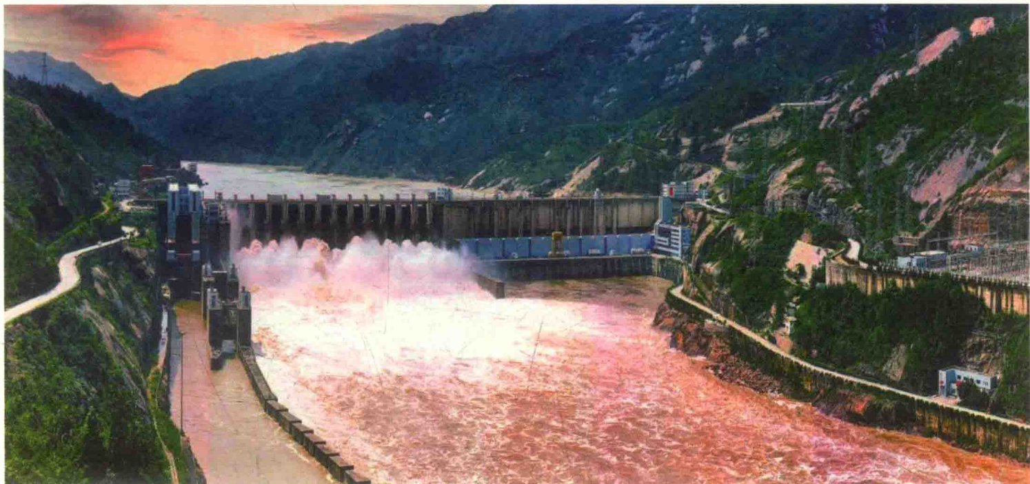
由福建省电力局利用世行部分贷款兴建的水口水电站，是华东地区最大的常规水电工程，装机7台总容量140万千瓦（摄于1996年）
