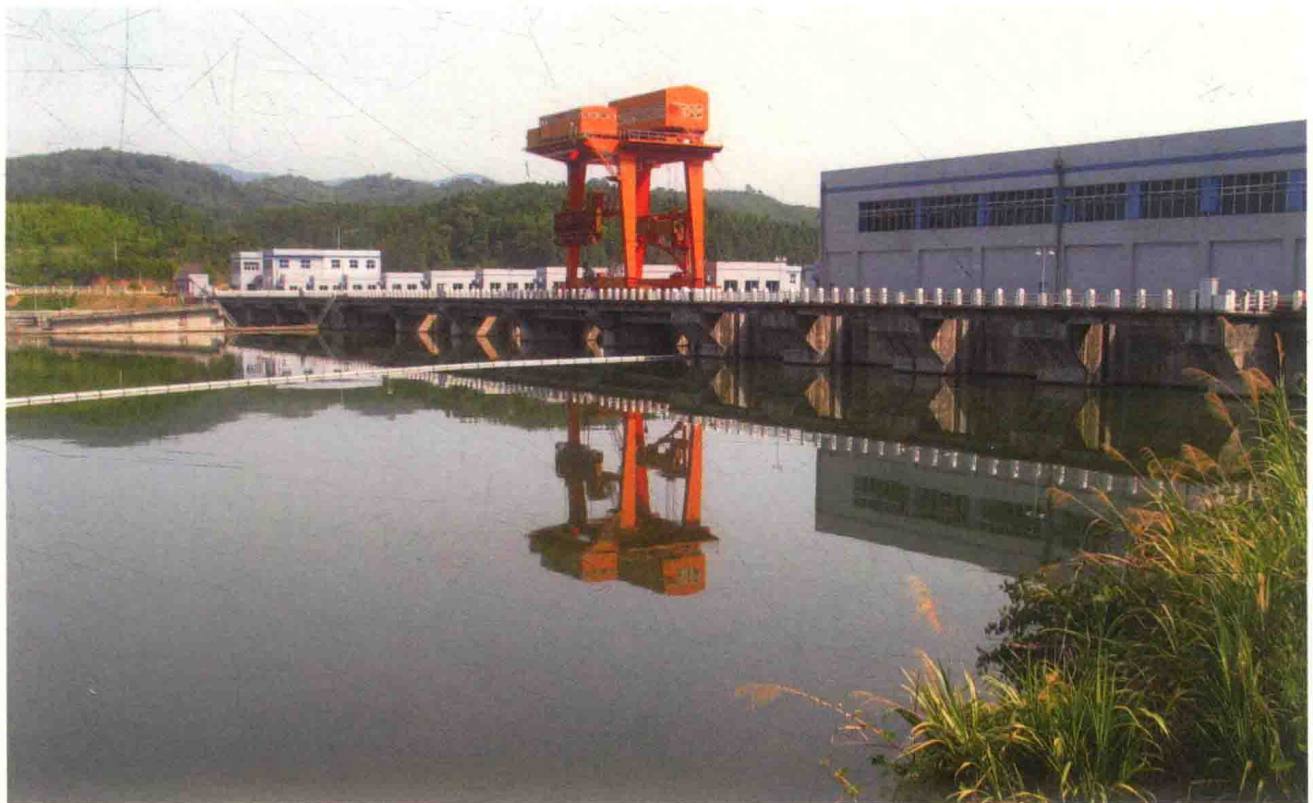
由福建省电力局、沙县水电开发投资公司、三明博源有限公司、福建投资开发总公司合资兴建的沙县高砂水电站，装机4台总容量5万千瓦（摄于1995年）
