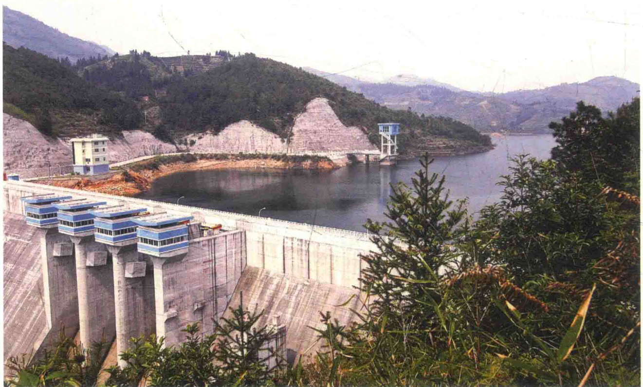
由福建省电力有限公司筹建并移交中国华电福建发电公司续建的闽东穆阳溪二级电厂周宁水电站，装机2台总容量25万千瓦（摄于2005年）
