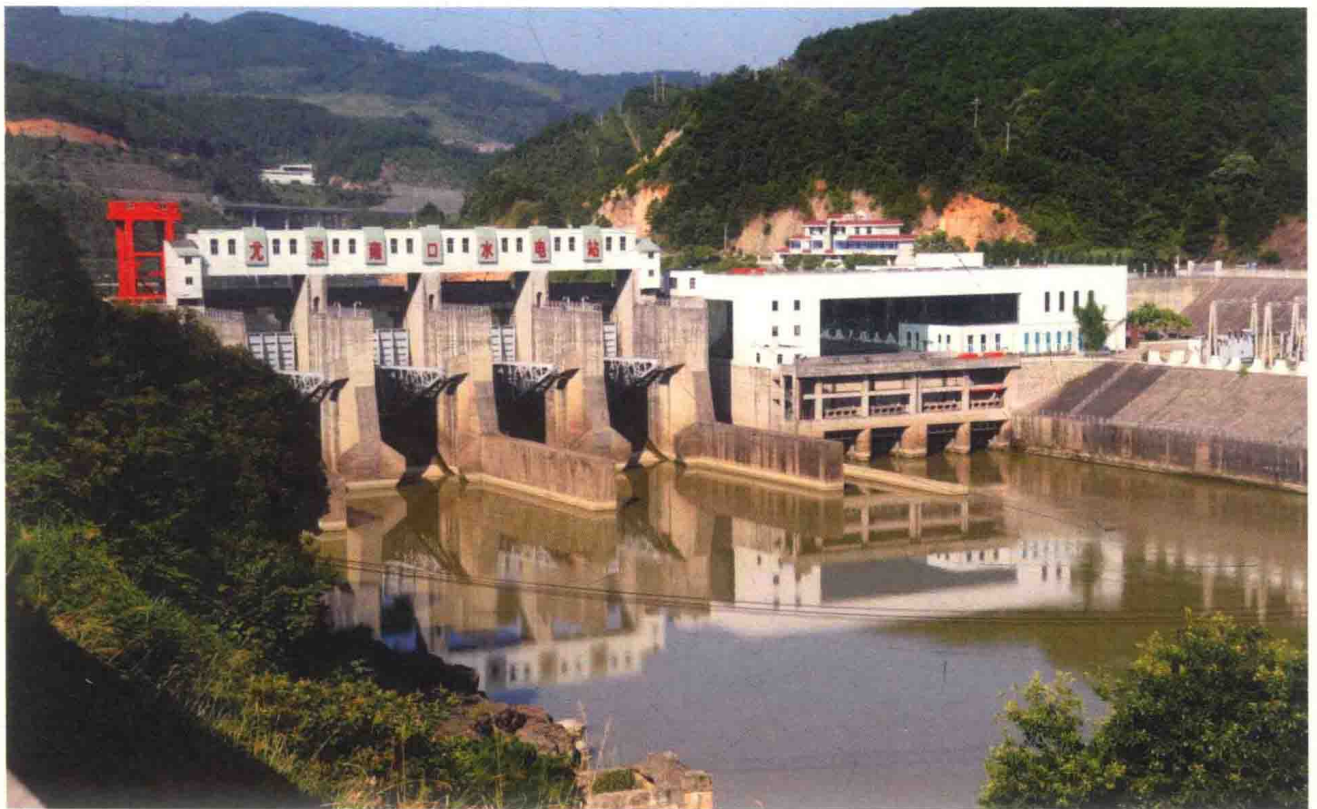
由福建省电力局、福建投资开发总公司、国家能源中型水电实业开发公司、尤溪县政府与福建亿力电力股份有限公司合资兴建的尤溪雍口水电厂，装机2台总容量5万千瓦（摄于1999年）
