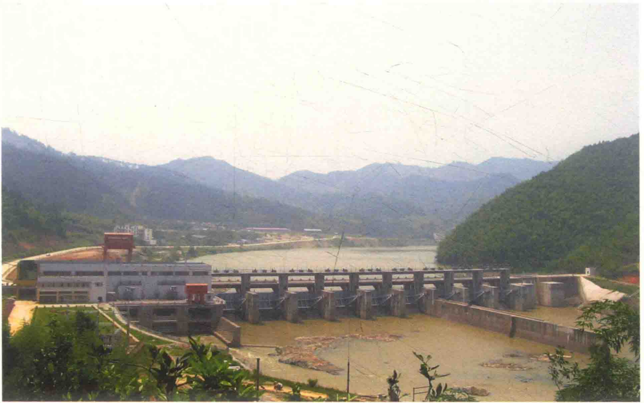
由福建亿力电力股份有限公司、三明市兴元水电开发投资有限公司、三明市竹洲水电劳动服务有限公司合资兴建的三明竹洲水电站，装机3台总容量5.4万千瓦（摄于2001年）
