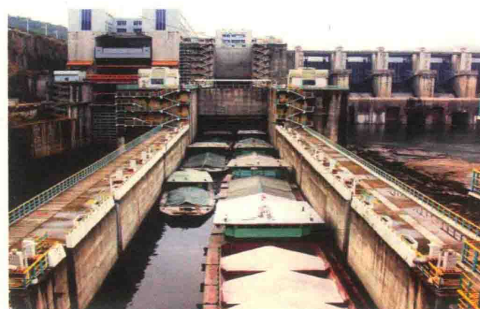
水口水电站一线三级船闸（摄于1996年）
