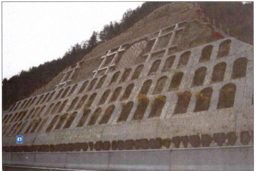
彩图 3 高速公路上的边坡防护工程
