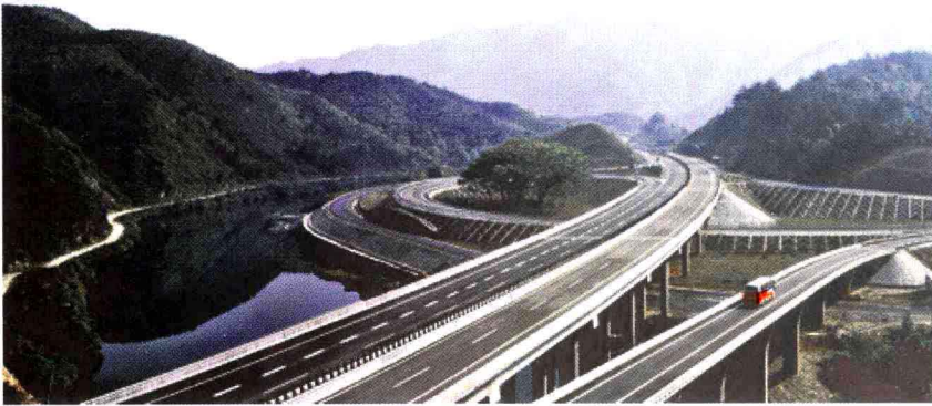
彩图 2 高速公路及立交桥
