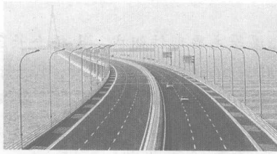
图 1-1-17 杭州湾跨海大桥
