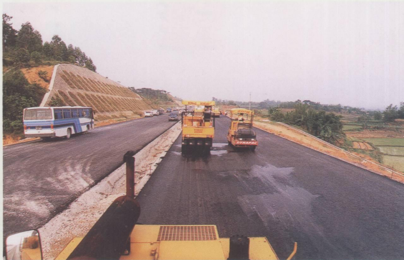
正在加紧施工的广肇高速公路
