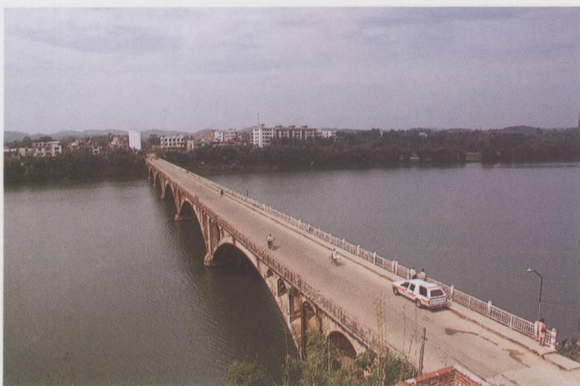
封开县南丰大桥——地方公路中的二级公路桥
