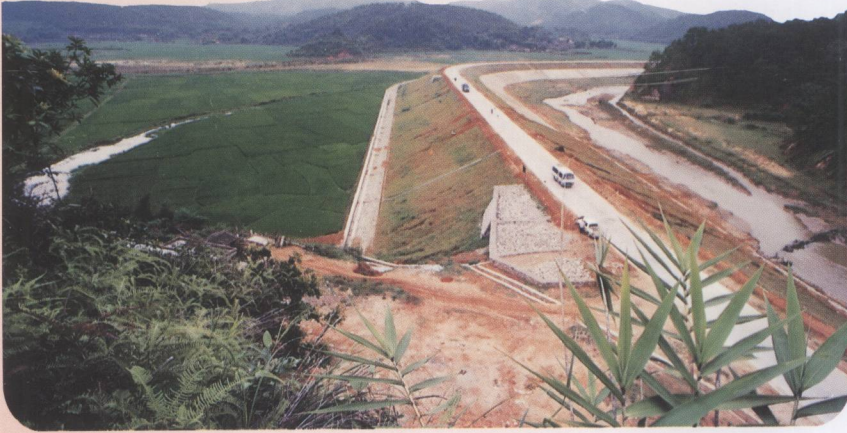
封开县谷圩堤全长3.17公里，捍卫4个行政村31个自然村，耕地面积7576亩，人口5580人。堤顶高程26米（主基），堤面宽12米，其中砼路面宽7米。谷圩堤是1998年度国债水利项目，工程投资2047万元。于1998年9月动工，1999年竣工。省道水谷线改由此经过。图为谷圩堤西段。
