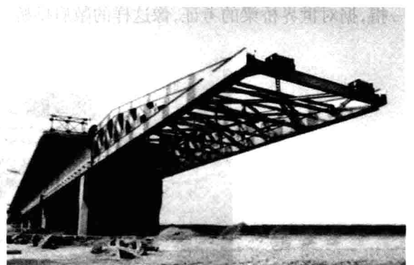
图0-5 顶推法施工
