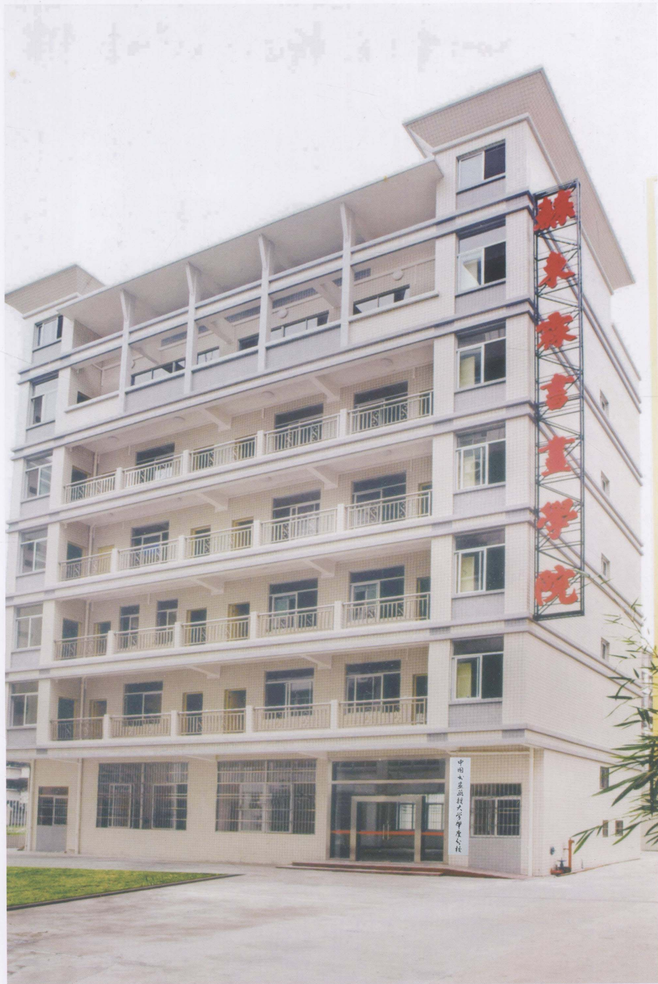
2005年5月，拆迁后重建的现校舍落成。
