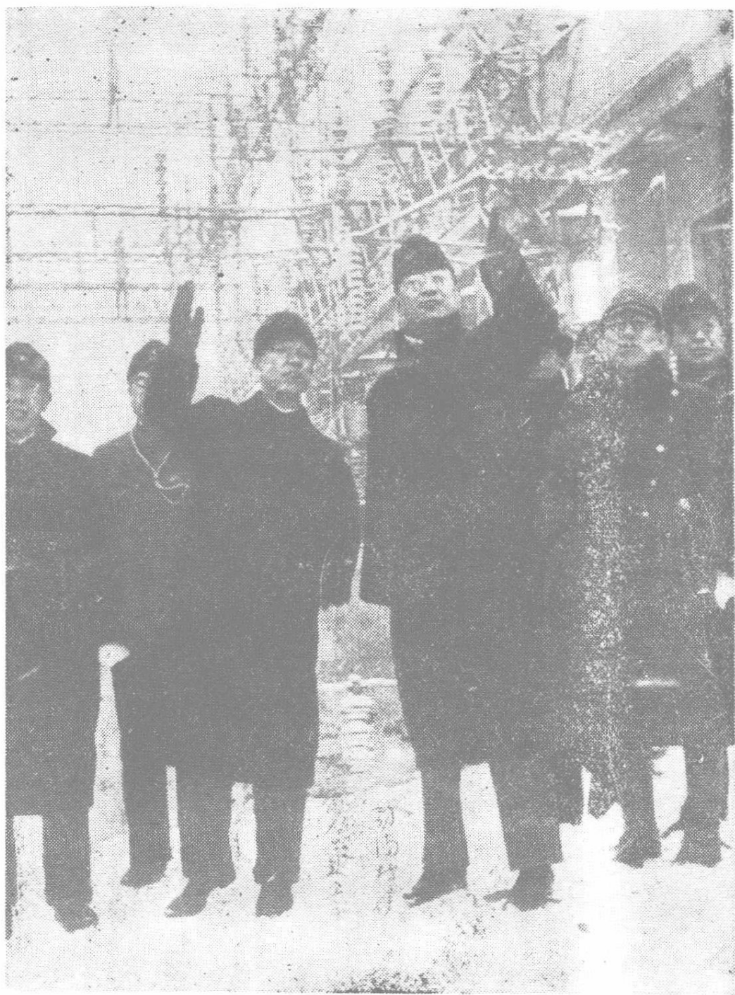
访“满”特使周佛海参观小丰满水电站
