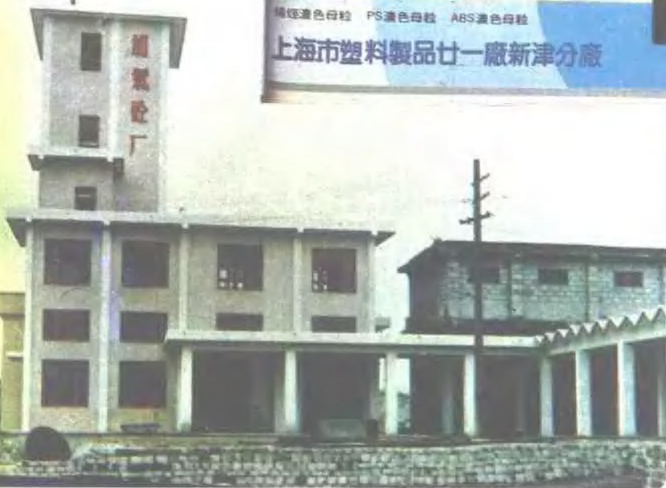
◀ 新津加气混凝土厂
