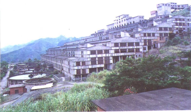
大厂矿务局车河选厂外景。(王崇礼摄)
