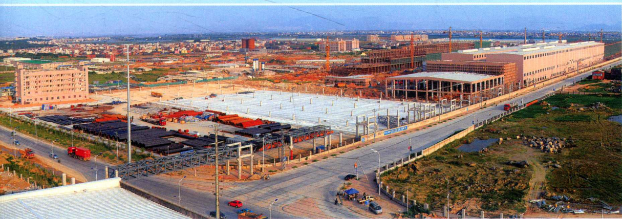
已初现规模的联盛纸业项目建设现场
