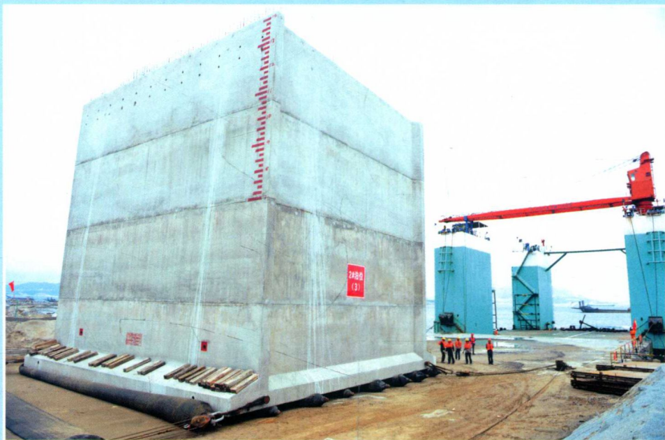
平潭港区金井作业区，一个巨大的预制混凝土沉箱在工人们的操作下缓缓出运装船
