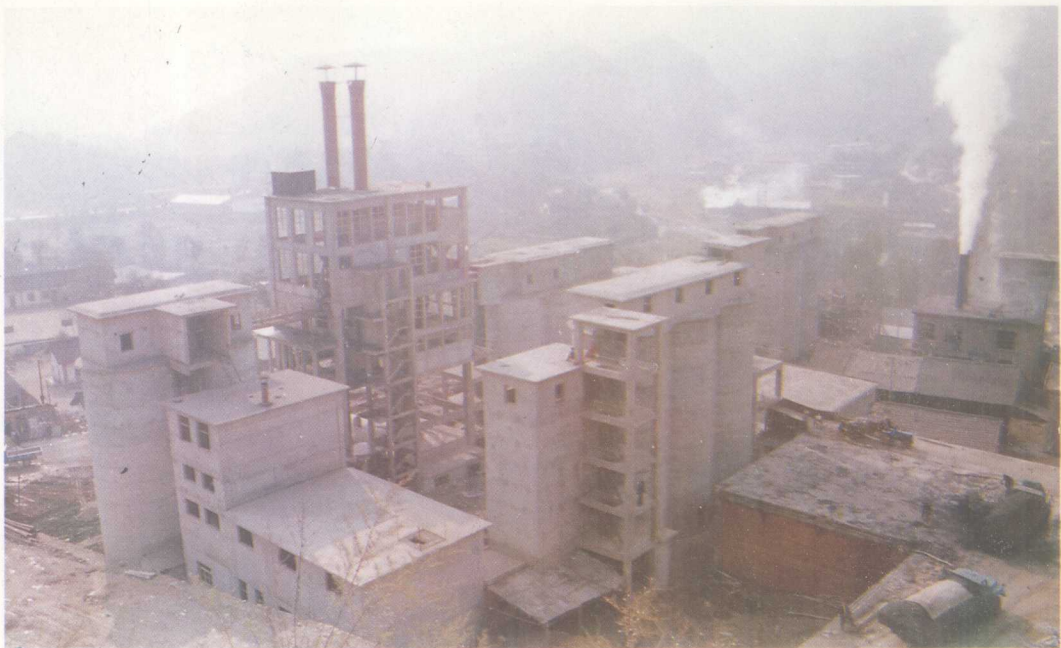
建设中的县水泥厂
