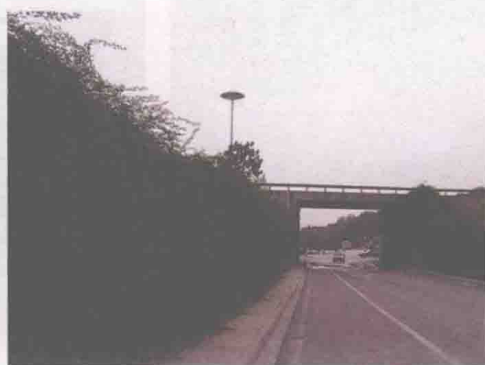
图 1-6 利用云南迎春覆盖高速公路路基，仿佛流淌着绿意的瀑布
