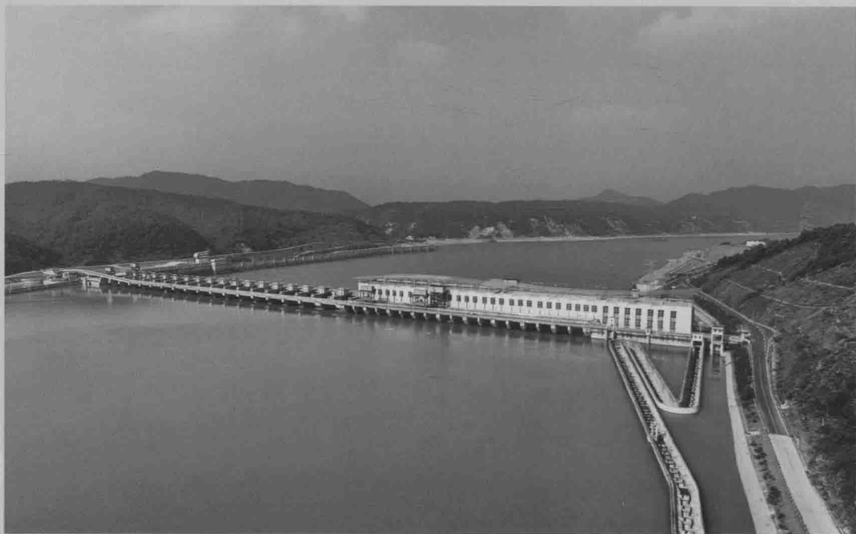
峡江水利枢纽工程鸟瞰（三）
