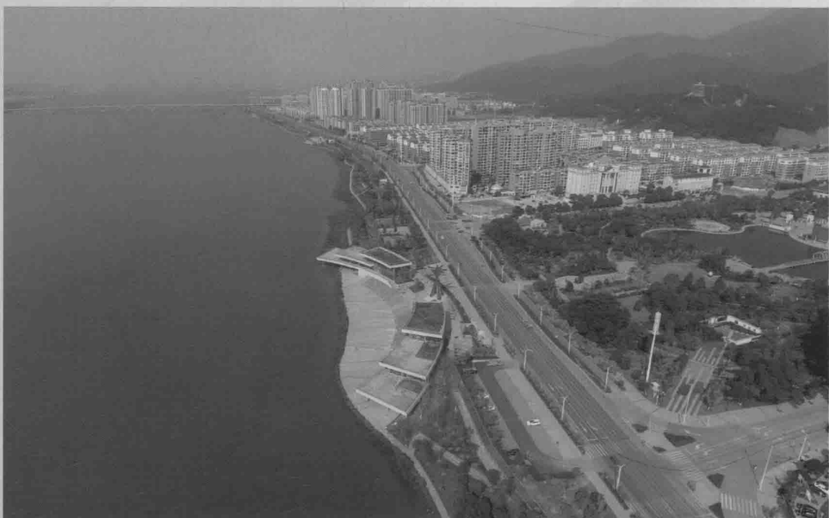
峡江库区防护工程吉水县城路堤结合工程
