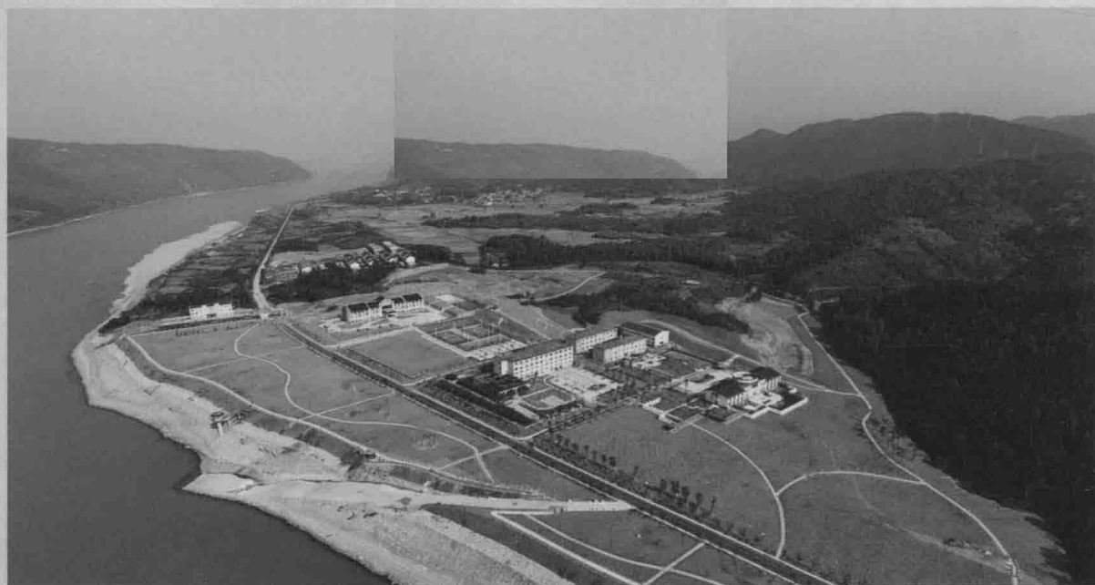
峡江水利枢纽工程鱼类增殖站
