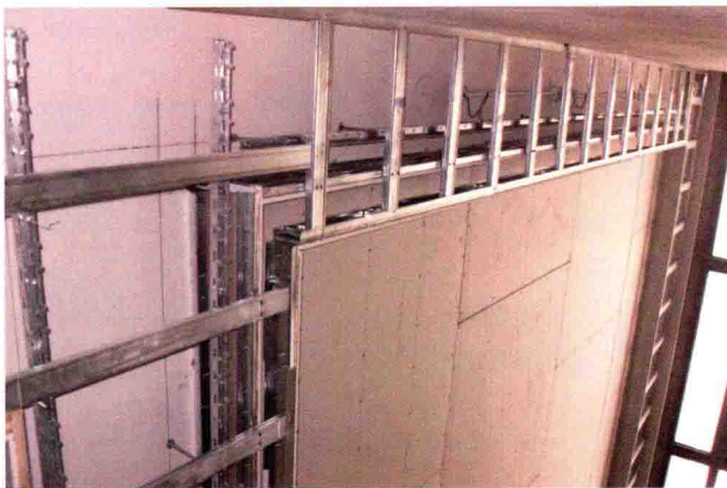
↑ 轻钢龙骨吊顶强度高，不容易变形
