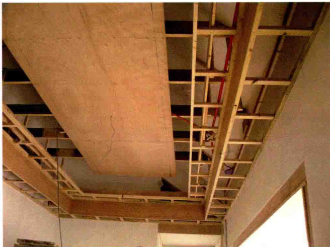
↑ 木龙骨可以在不平整顶面安装吊顶
