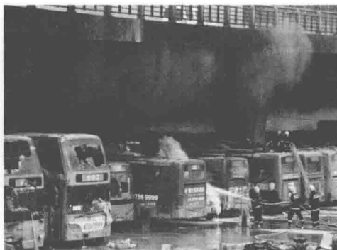
图 1-20 江西南昌生米大桥气割操作不当引发火灾
