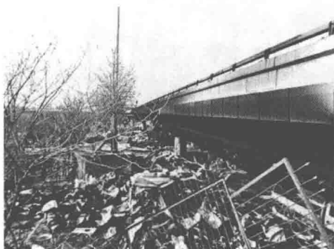
图 1-17 北京北五环肖家河桥桥下建筑引发火灾
