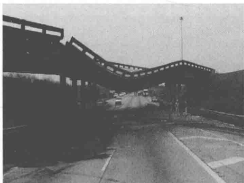
图 1-1 I-65 公路某桥梁(2002)
