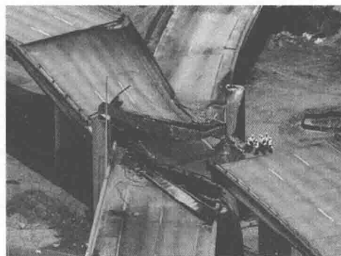
图 1-4 奥克兰海湾大桥引桥(2007)
