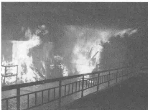
图 1-13 陕西宝鸡南关桥墩间堆积物引发火灾
