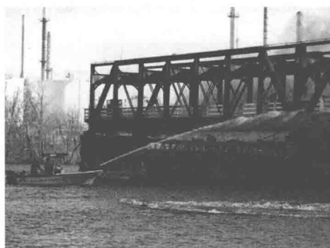
图 1-5 Rock Island Swing Bridge(2010)
