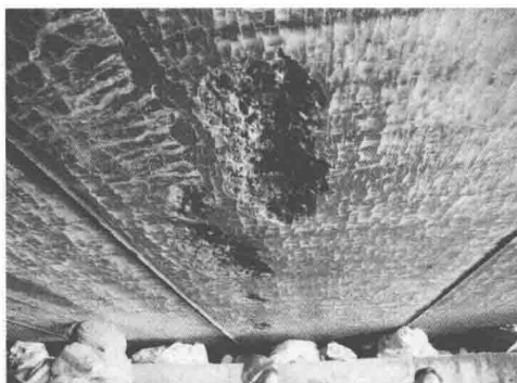
图 1-19 西攀高速公路王家沟中桥桥下竹林起火
