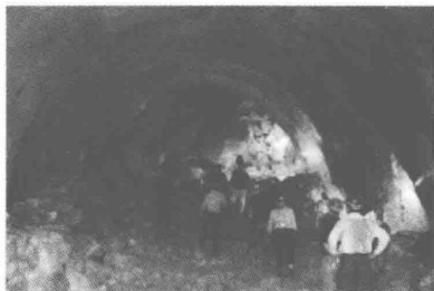
图 1-2 某隧道塌方
