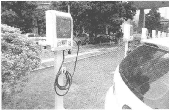
(a) 插电式交流(非直流)充电设备
