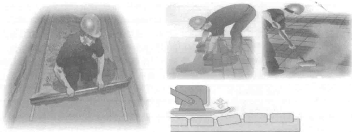
图 1-1 意大利路基砂垫层和混凝土块路面铺筑
