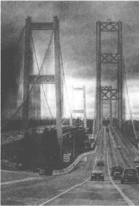
图 1-1-5 新修的塔科马海峡大桥(右边)
