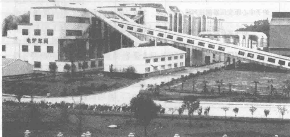
图 1-3 采用胶带输送机上料的铁合金厂全貌
