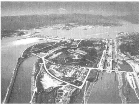
图 0-1 长江三峡水利枢纽工程
