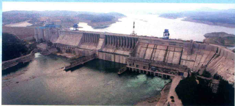
丹江口水利枢纽全景
