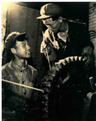
（左一）1957年武钢开工兴建后，宋恩厚经常利用工余时间在施工现场收集创作素材。（1958年新华社记者于澄建拍摄）
