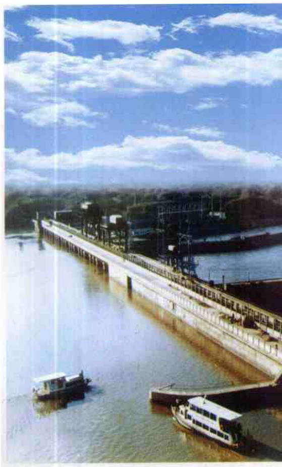
青铜峡拦河大坝水利枢纽工程
