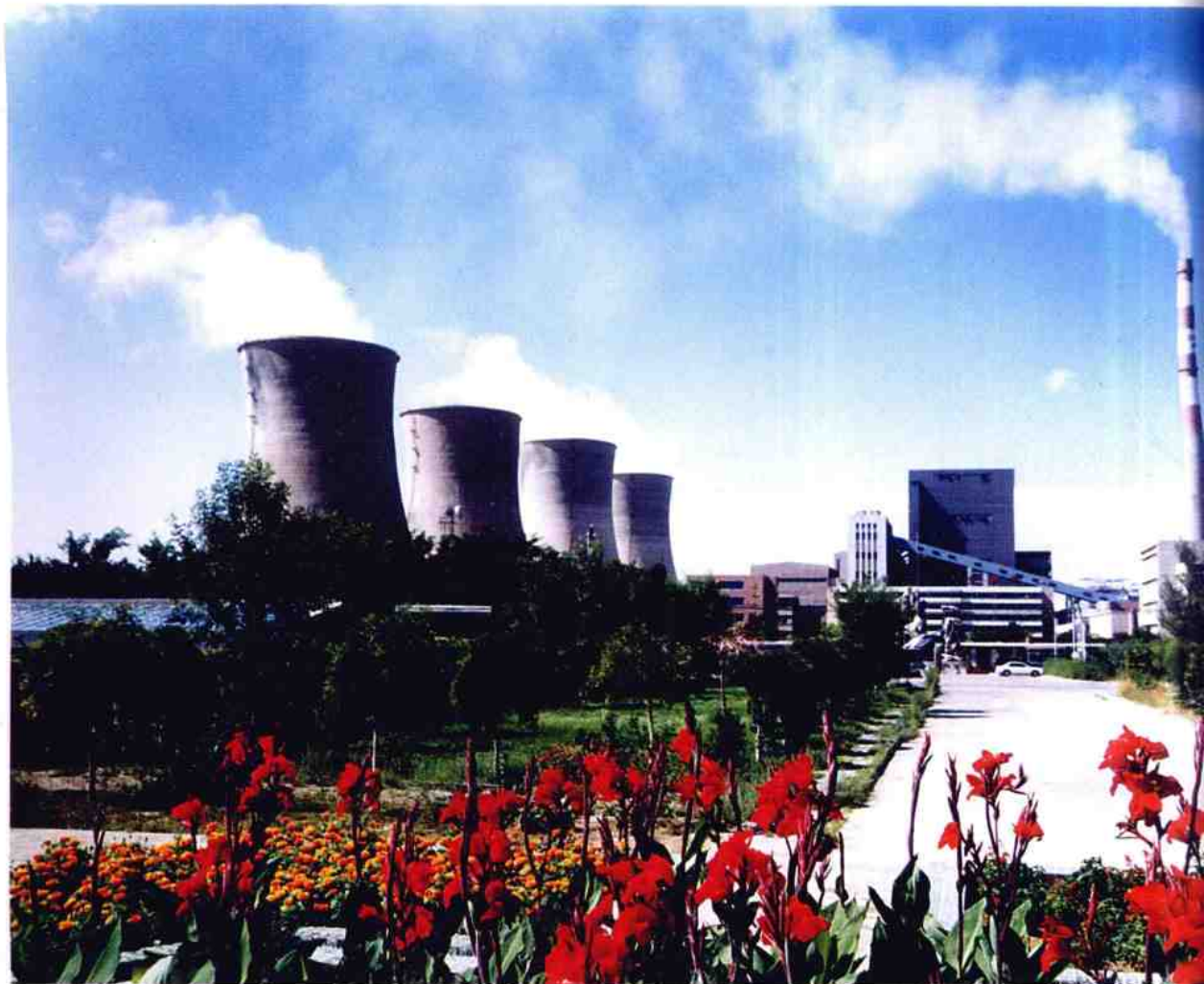
宁夏青铜峡大坝发电厂——厂区一角
