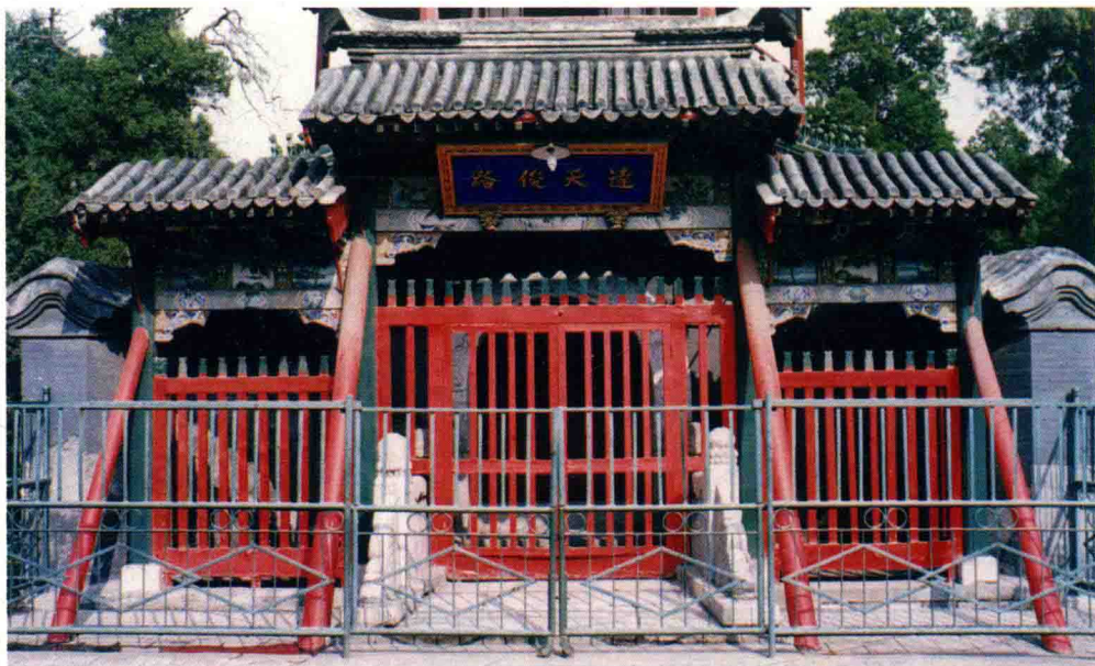
▲ 楼前木牌坊及汉白玉石桥、檐下有“达天俊路”匾
