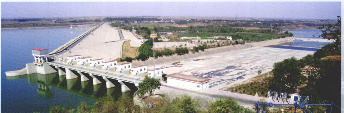
◆ 黄壁庄水库主坝及正常溢洪道
