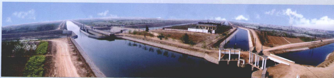
◆ 民有渠北张庄枢纽
