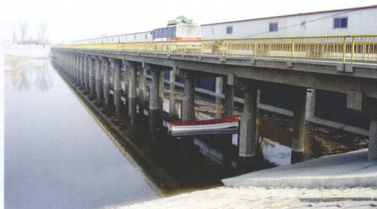
◆ 二十五孔闸上游斜视图
