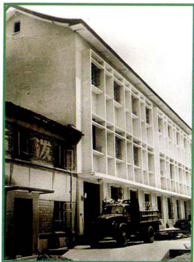
1985年县局电信大楼
