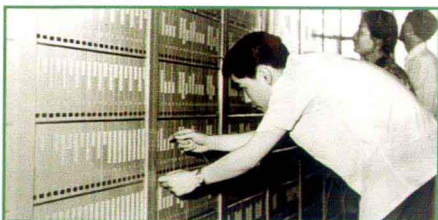
80年安装 NJ-101 准电子自动交换机 1000 门的机房一角
