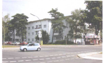
图0-5 “汤姆叔叔住宅区”沿街外景
