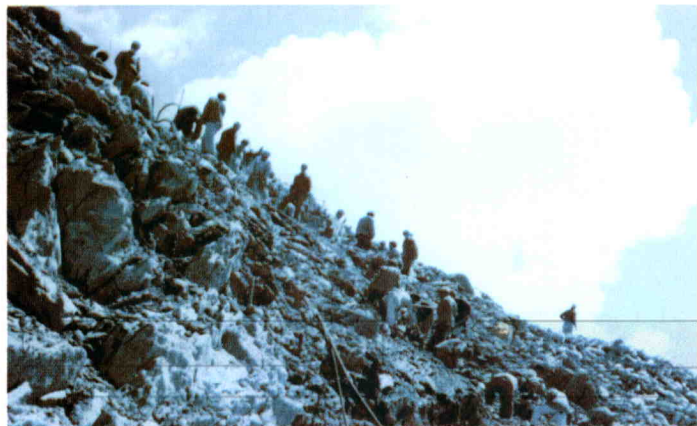
◀八团前身——兵团水利工程处 一团修筑乌 库公路 (1957年)
