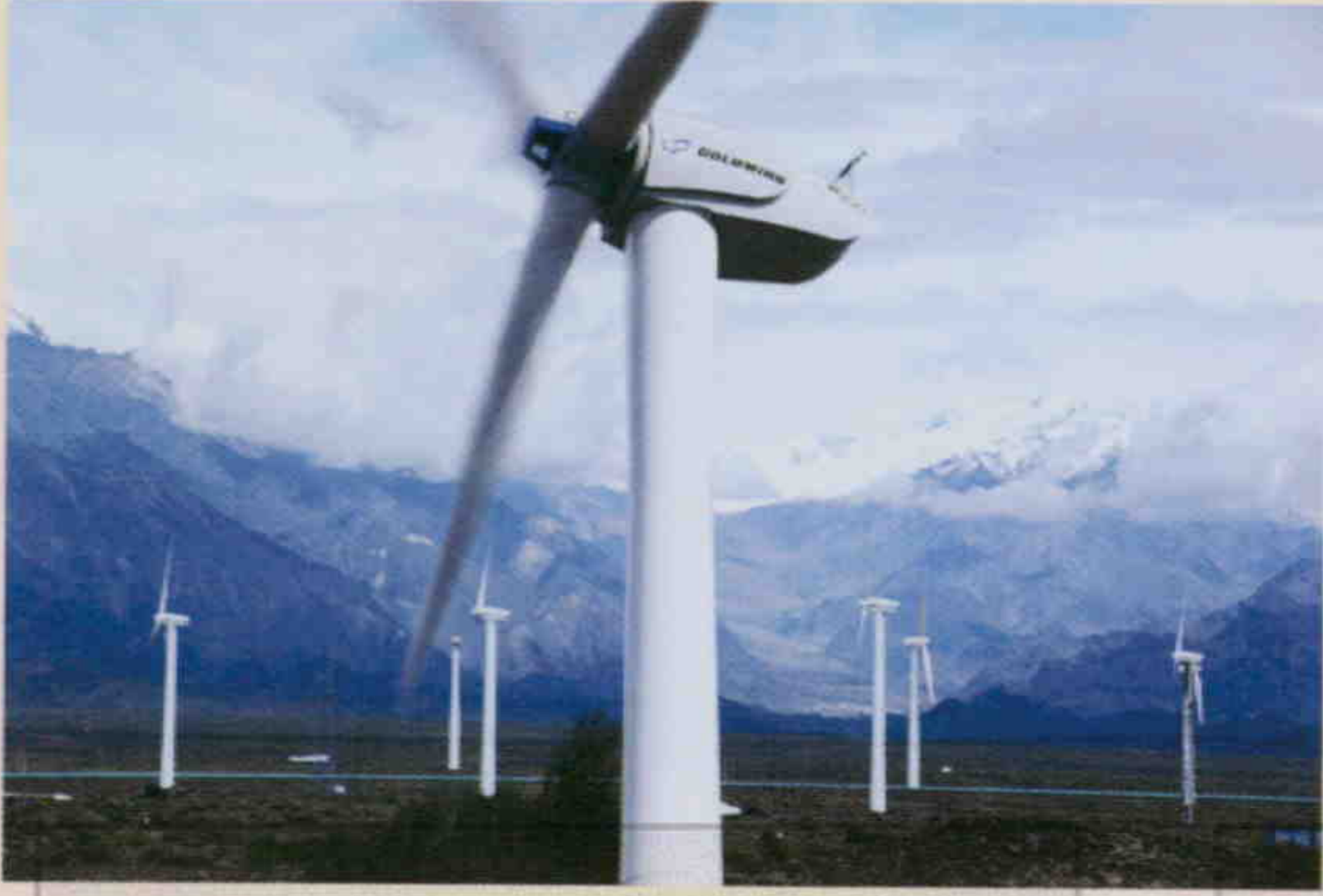
新疆金风科技股份有限公司750kW风力发电机组特写
