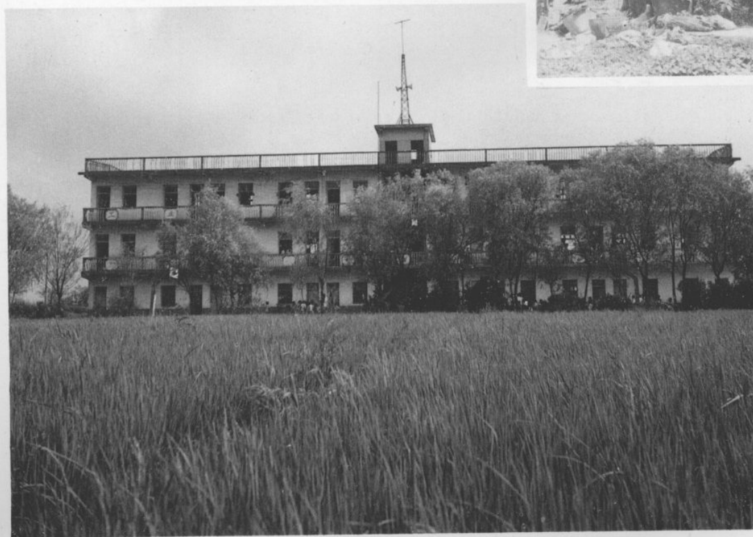
漕河小学教学大楼
