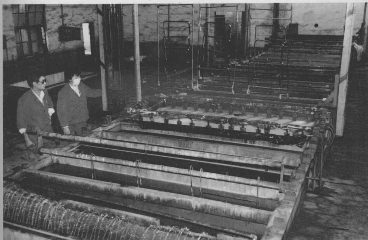
漕河电镀厂车间
