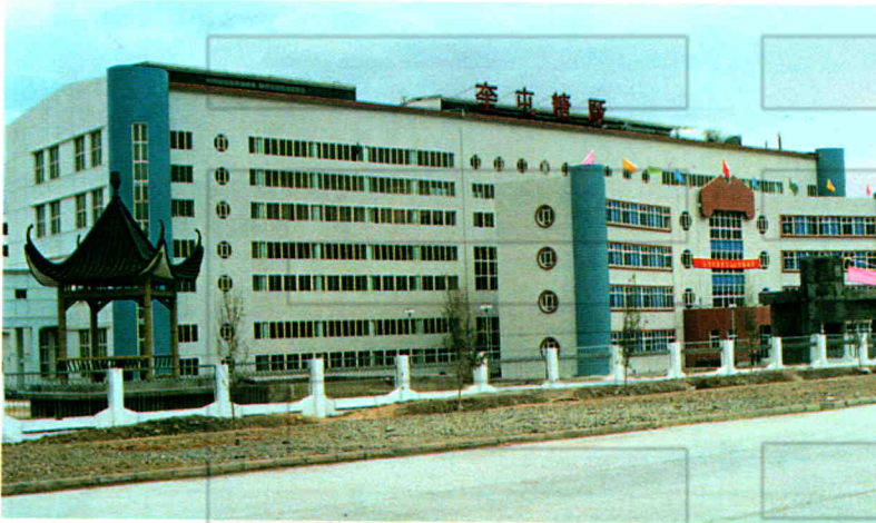
师建安公司承建的糖厂主控楼
