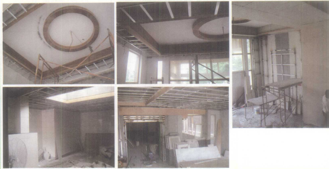
图1.11 住宅空间设计施工现场照片 文健 摄
