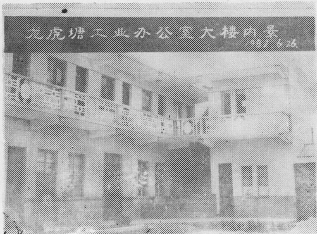
龙虎塘乡工业办公大楼
