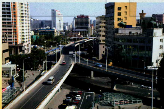
新建乌鲁木齐市外环路胜利路匝道
