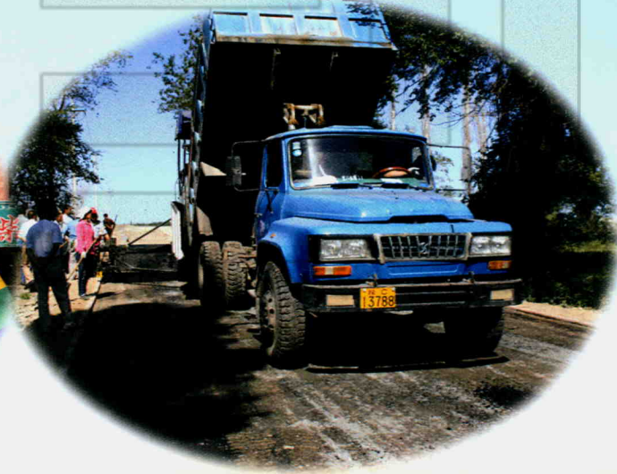
2008年6月5日,水磨沟区 七道湾村道路建设施工现场
