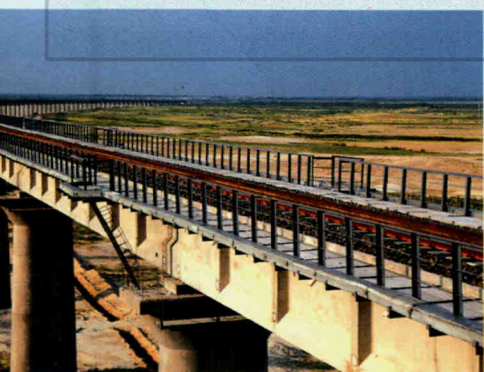
2009年建成奎北铁路盐田特大桥
