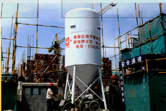
预拌砂浆在现场使用
