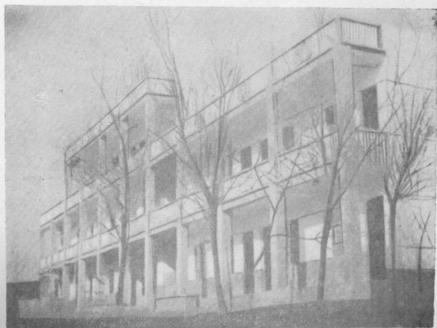
汤庄桥中心小学教学大楼
