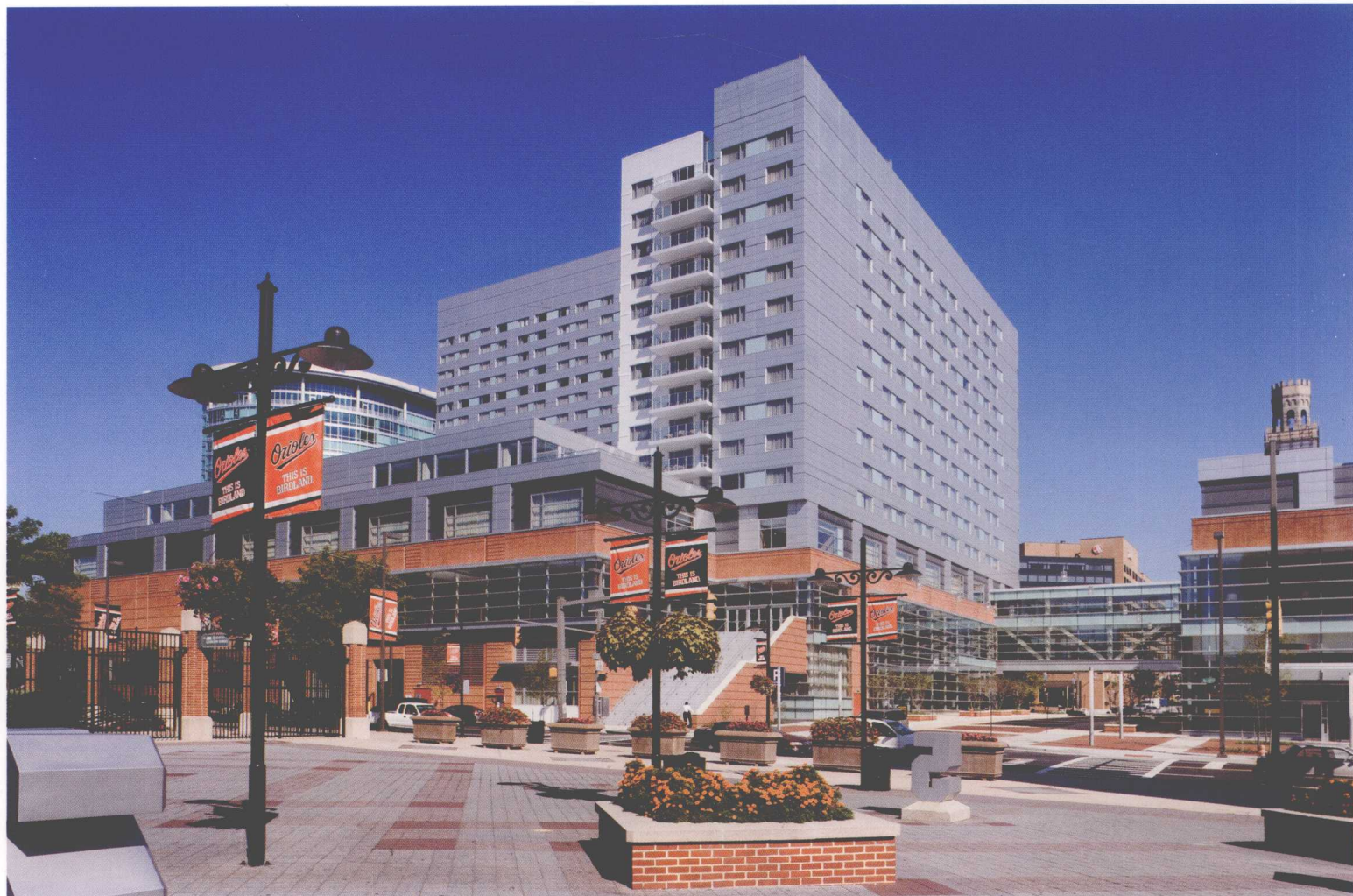
General view 全景图
