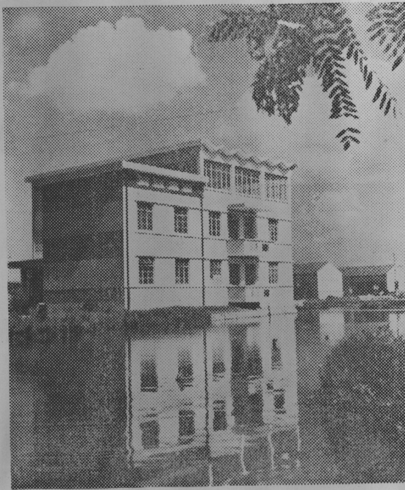
青龙修建站办公楼
