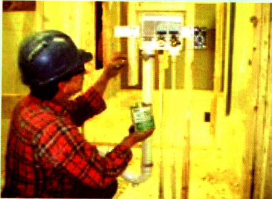
图1.1-10 安装水、煤气管道
