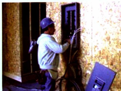
图1.1-12 安装配电盘
