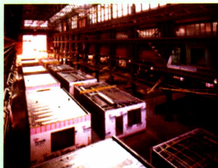
图1.1-6 住宅装配生产线
