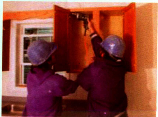
图1.1-11 安装吊柜
