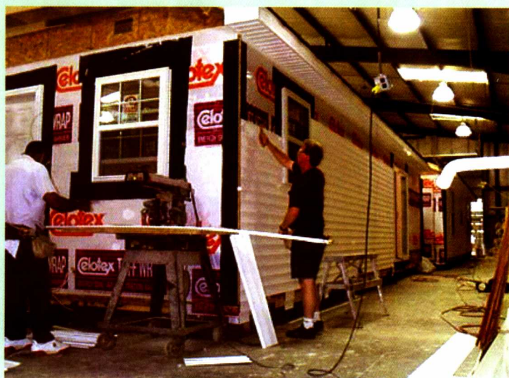
图1.1-7 装配外墙挂板
