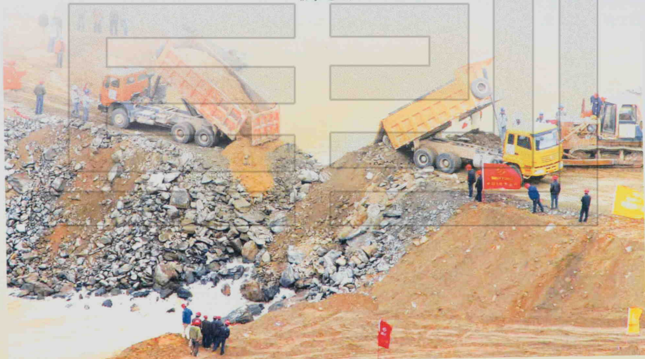
2010年6月24日,大型水利工程克孜加尔水库合拢现场
