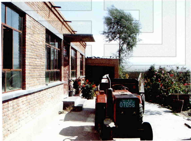
砖木结构房屋及庭院（摄于2007年9月15日）
