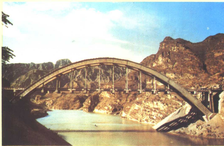
◀ 中国最大的钢筋混凝土铁路拱桥——丰沙线永定河七号桥
