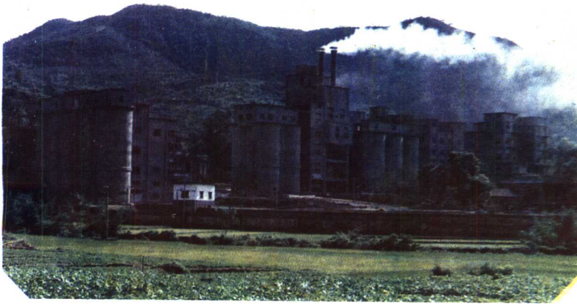
▲油坑水泥总厂厂貌
