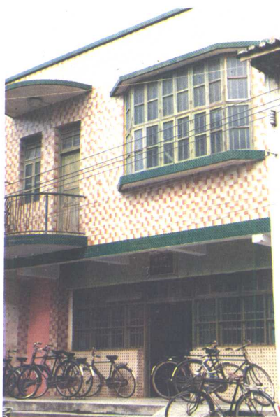
镇建筑工程队办公楼
